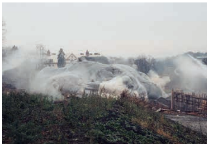
Další ukázka dobře fungující komplexní ochrany při odstřelu prádelny Masarykovy nemocnice 28. listopadu 1992 Vlevo zachycení rozletu z D. Ř., vpravo nafukování textilie a cezení bílého dýmu po ukončení pádu a drčení zdiva
