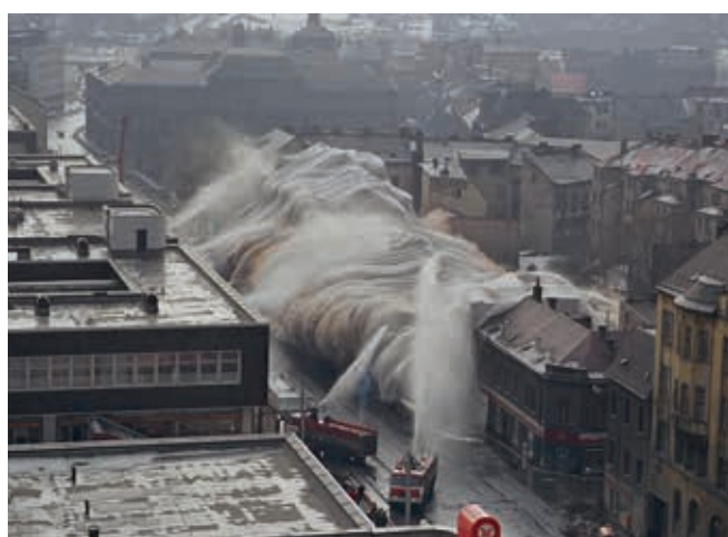
Odstřel 9 čtyř- až pětipodlažních domů v Ústí n. L., ulici Masarykova 7. února 1987 (foto ze střechy hotelu Vladimír)
