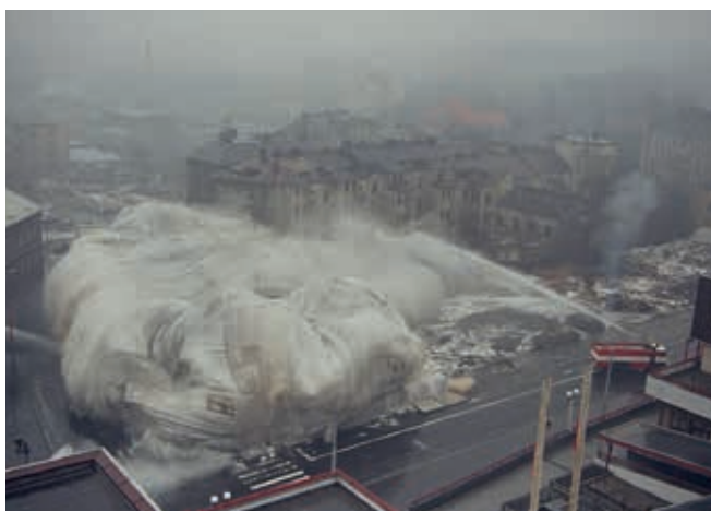
Odštěl 6 objektů v ulici Leninova u Městských sadů 28. února 1987. Na levé fotografii geotextilie zachycuje rozlet úlomků zdiva z destruktčních řezů v úrovni prvního patra, vpravo dokončen pád budov – geotextilie je nafouknutá hrubým cihelným prachem a přes textili se „cedí“ pouze jemný bílý prach ve formě bílého dýmu.
