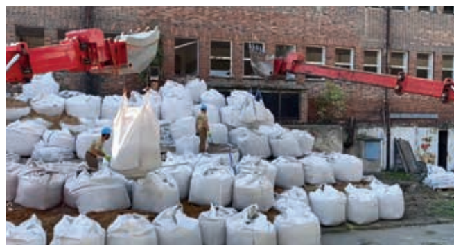
Stavba ochranného valu (druhý den)
