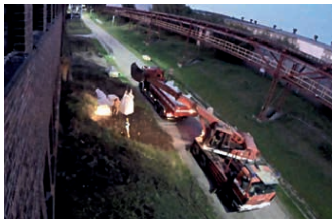
Stavba ochranného valu (první den)
