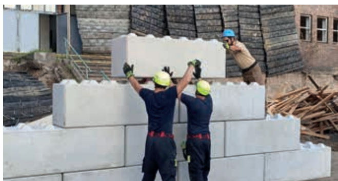
Stavba ochranné zdi – „lego“ kostky
