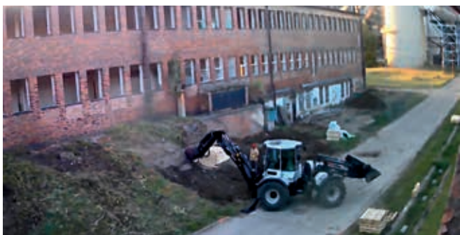
Terénní úpravy v okolí pumy
