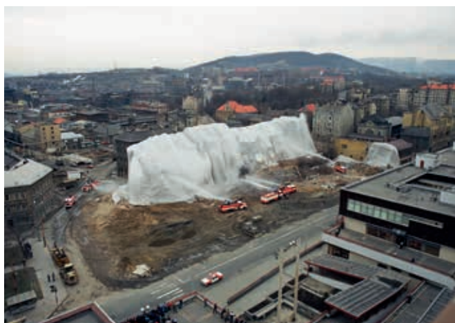
Odštěl 6 objektů v ulici Leninova u Městských sadů 28. února 1987. Na levé fotografii geotextilie zachycuje rozlet úlomků zdiva z destruktčních řezů v úrovni prvního patra, vpravo dokončen pád budov – geotextilie je nafouknutá hrubým cihelným prachem a přes textili se „cedí“ pouze jemný bílý prach ve formě bílého dýmu.
