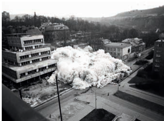
Ul. V. Hradební – kvůli nulovým zkušenostem s montáží geotextilního obalu nebyl výsledek dle našeho očekávání.
