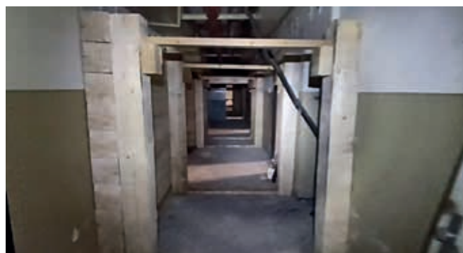
Trámové přepážky ve spodní části budovy
