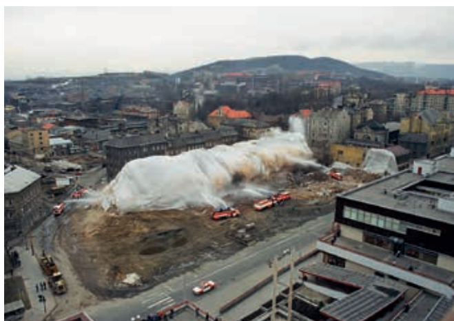
Odštěl 8 objektů v ulici Moskevská 28. března 1987. Na fotografii v pádu je zachyceno roztržení geotextilie uprostřed a výron tmavě hnědého prachu zpod geotextilie, který je však okamžitě zlikvidovaný vodními děly hasičů
