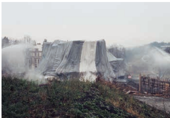
Další ukázka dobře fungující komplexní ochrany při odstřelu prádelny Masarykovy nemocnice 28. listopadu 1992 Vlevo zachycení rozletu z D. Ř., vpravo nafukování textilie a cezení bílého dýmu po ukončení pádu a drčení zdiva
