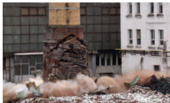
Obr. 2 Detail výtrže zvětšené „tlamy“ DŘ. během počátečního náklonu při způsobu odstřelu „na zkrácení“ (areál firmy DTZ Liberec 20. 2. 2022)
