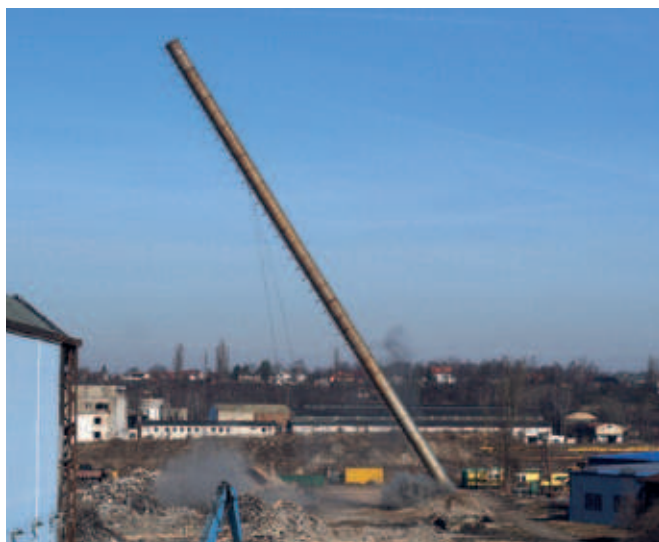
Obr. 8 Odstřel ocelového komína výšky 66 m bez zalomení (Poldi Kladno 4.3.2017)
