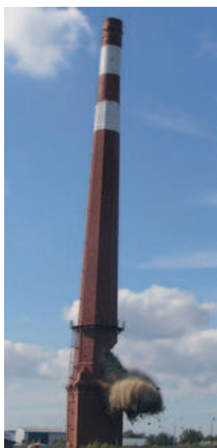
Obr. 11 b Celý rozlet zachycený geotextilií (Holešov u Brna 29. 9. 2007)
