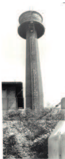
Obr. 15 věžový zděný vodojem na komíně (Agrozet Roudnice odstřel 21. 8. 1986)
