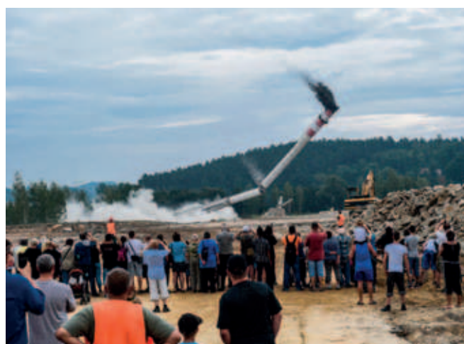
Obr. 7 Zalomení 100 m žb monolitického komína (Diamo Hamr na Jezeře 28.8.2015)
