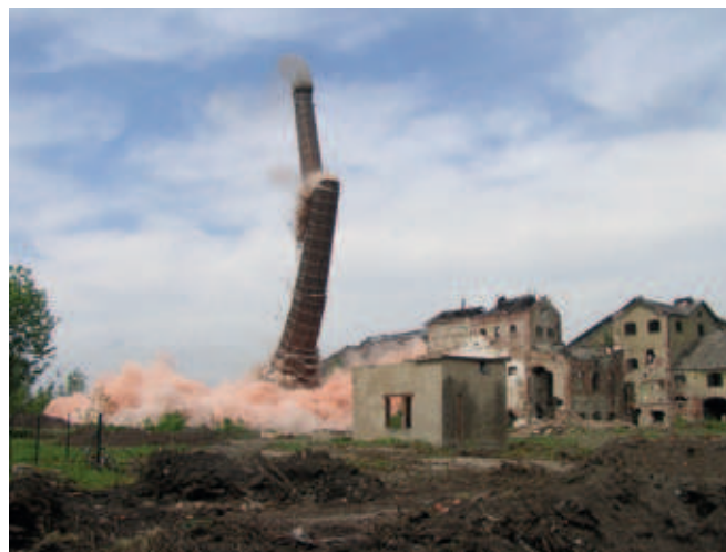
Obr. 5 Několikanásobné zalomení před dopadem (cihlový – pivovar Chomutov 11. 5. 2011)
