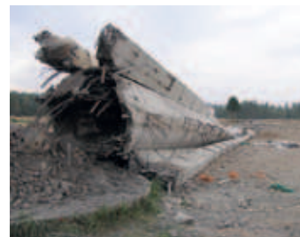
Obr. 17, 18, 19 Železobetonový komín s křídly „raketák“, Diamo Ralsko – Hamr na Jezeře výška 100 m, odstřelen 28. 8. 2015
