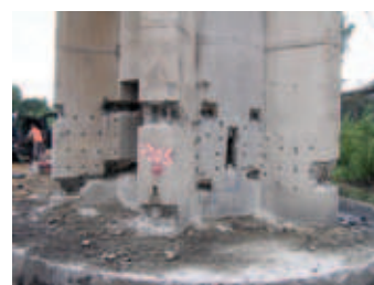
Obr. 16 Extrémní tloušťka zdiva 240 cm – bylo nutné odbourat rohy ortogonálního dřívku, použity vnější i vnitřní vrty hl. 80 cm (cukrovar Lenešice u Loun)
