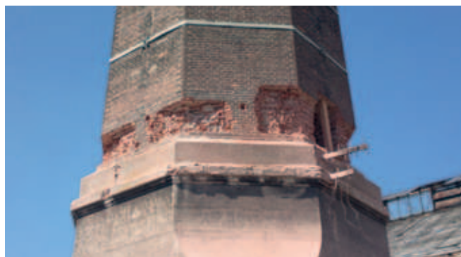
Obr. 16 Extrémní tloušťka zdiva 240 cm – bylo nutné odbourat rohy ortogonálního dřívku, použity vnější i vnitřní vrty hl. 80 cm (cukrovar Lenešice u Loun)
