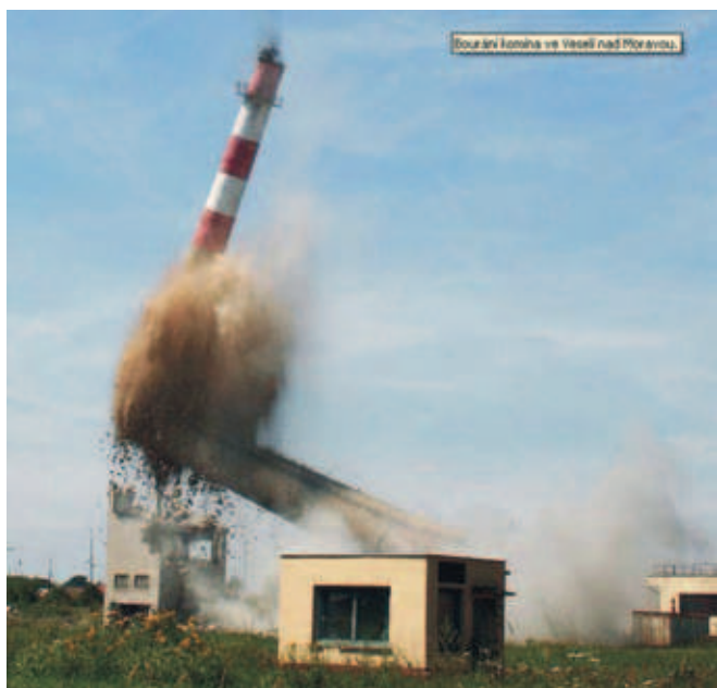
Obr. 4 Odstřel se zalomením komína (železářny Veselí n. M – 29. 7. 2009)
