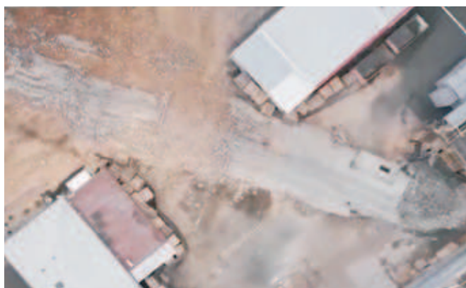
Obr. 20 – Přesné nasměrování žb tvárnice komína mezi stávajícími objekty v areálu firmy Partner Pet Food ve Veselí nad Lužnicí dne 25. 5. 2021
