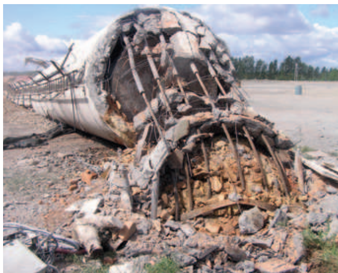
Obr. 10 Pata betonového komína ze skruží s ocelovými táhly po odstřelu
