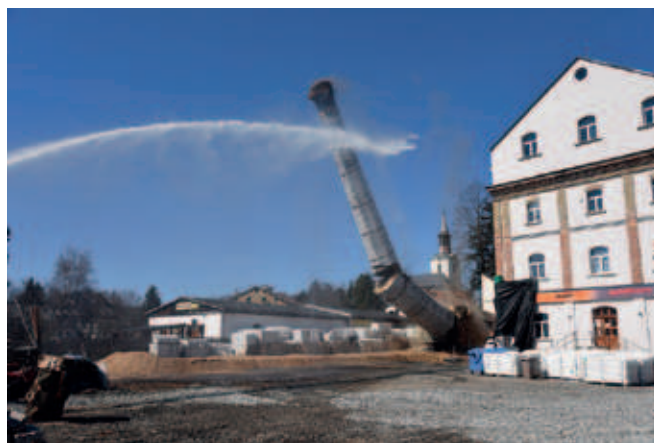
Obr. 1 Odstřel komína způsobem „na položení“ (RICOM GAS Cvikov 6. 4. 2018)
