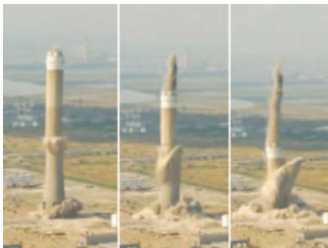
Obr. 3 Fáze odstřelu komína způsobem „do sebe“ (CDI, Anglie, hrabství Kent (250m) – 7. 9. 2016)
