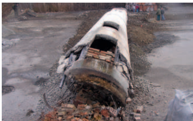
Obr. 14 Komín po dopadu do tlumícího (Morkovice 24. 1. 2012)
