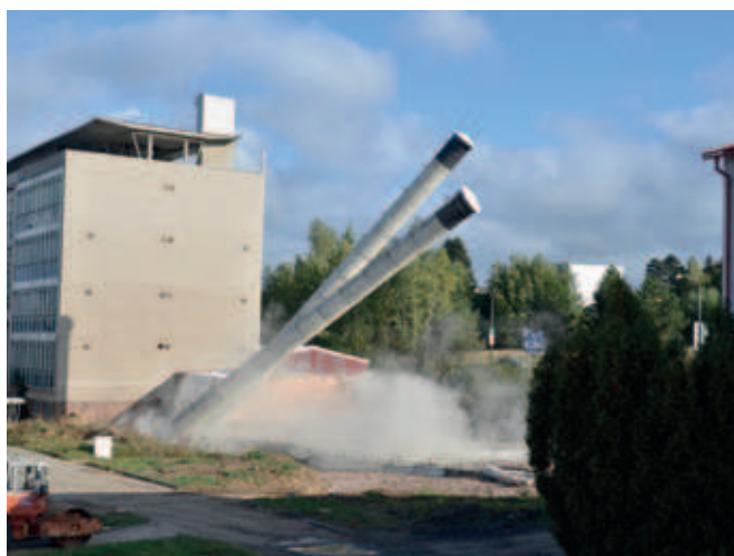
Obr. 9 Komíny z betonových skruží bez zalomení (Dioptra Turnov 8. 10. 2016)
