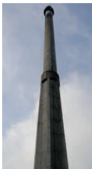
Obr. 17, 18, 19 Železobetonový komín s křídly „raketák“, Diamo Ralsko – Hamr na Jezeře výška 100 m, odstřelen 28. 8. 2015
