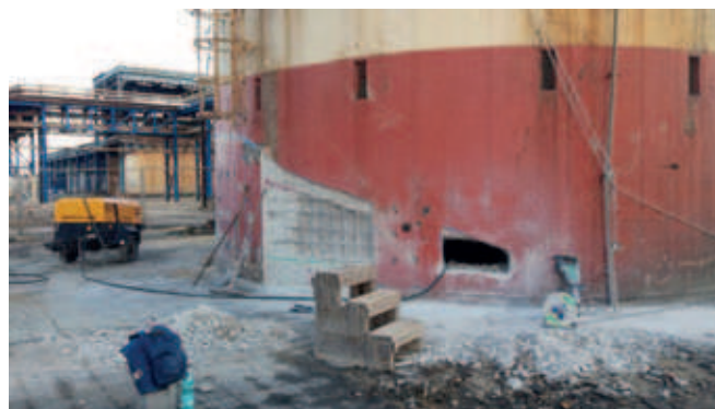
Obr. 21, 22, 23 Příklady vybouraných klínů na přímce zlomu – kloub otáčení
