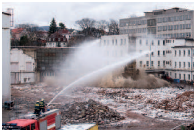
Obr. 12 Zásah hasičů během pádu komína (areál DTZ Liberec 20. 2. 2022)
