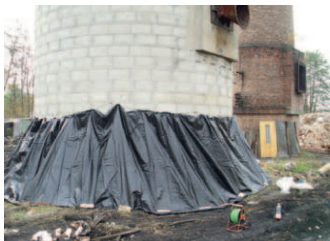
Obr. 11a Ochrana proti rozletu a tlakovzdušné vlně z geotextilie (Bojkovice 29. 10. 2011)
