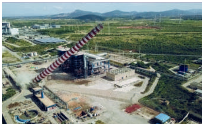
Obr. 13 Tlumící násep se záchytným valem na konci náspu (Sardinie, Fiume Santo 6. 6. 2018)
