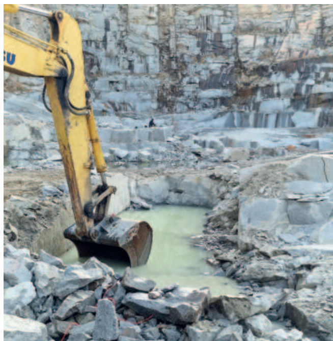
Obrázek 4: Hladký výlom, uvolnění nepoškozeného bloku
