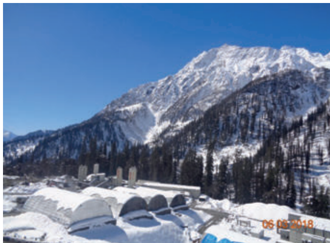
Obr. 4: Pohled na ZS tunelu Rohtang u jižního portálu – více než 3000 m nad mořem
