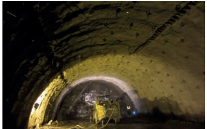
Obr. 9: Dvě řady LSC, 1 řada LSC poblíž čela kaloty, NP v červenci 2015
