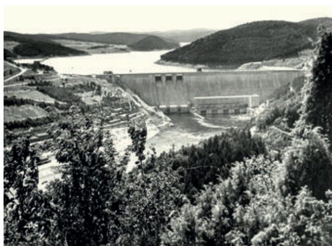
Hráz po dokončení
