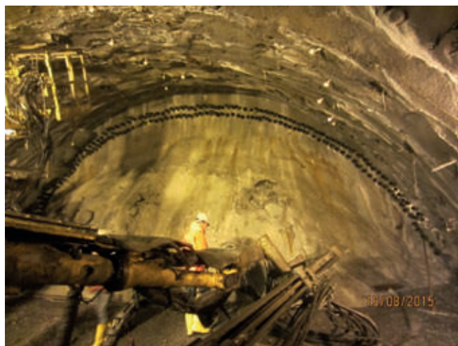
Obr. 7: Montáž dvouřadého dešťníku o průměru 114 mm ve st. 2+413 až 2+445
